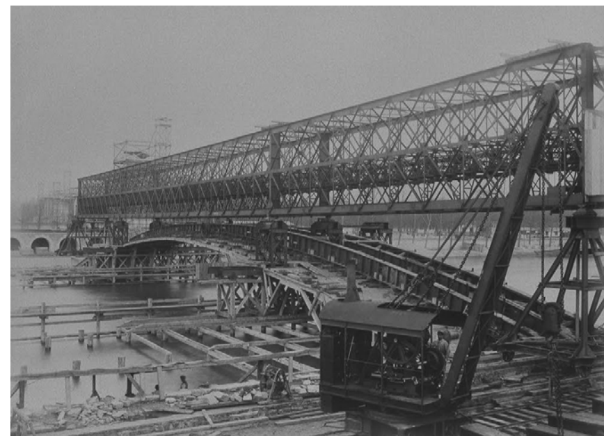
Fig. 7. Proceso de construcción: su gran arco, sustentado por una cimbra provisional de madera, dispuesto para soportar la estructura metálica que se desplazará hasta alcanzar el otro lado del Sena, alcanzando los 107,50 m, aunque su longitud total es de 160 m, para poder instalar y fijar su tablero. Fotografía: BnF
